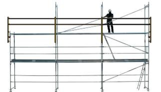
7. Antes de acceder al nivel superior, instalamos la barandilla de montaje. Asegurada la barandilla, instalamos los elementos del nivel superior.
