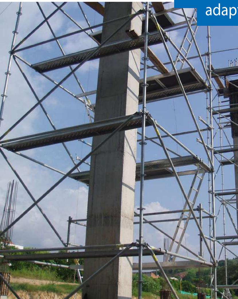
El sistema de andamio Multidireccional NOPIN se caracteriza por su versatilidad y flexibilidad a la hora de ejecutar cualquier tipo de trabajo en altura adaptándose a todo tipo de edificios o estructuras.
